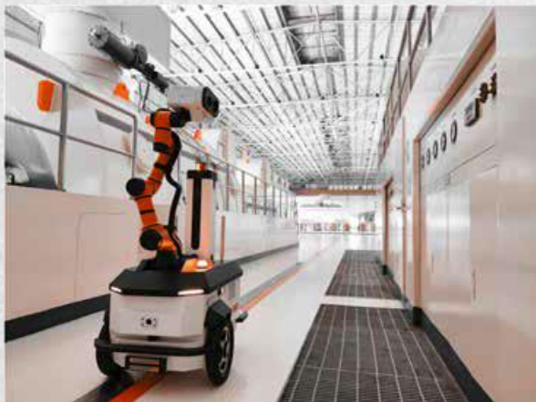
电力行业巡检
