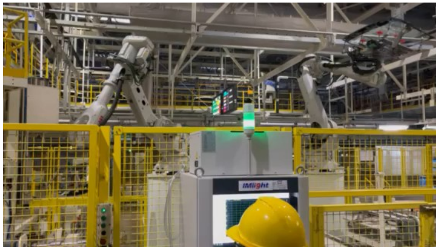
东风日产常州工厂 现场运行视频
