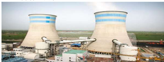
国电天津东北郊热电厂 38.8MW×8
