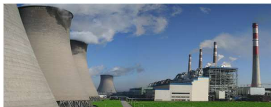
邢台国泰发电厂有限公司 26.3MW×9
