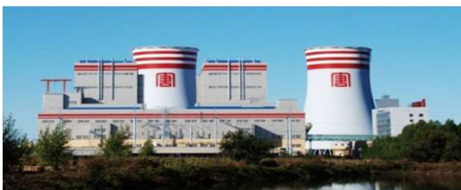
大唐哈尔滨第一热电厂 38.8MW×8
