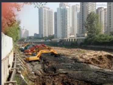
防爆开挖和河道涵洞清淤疏浚
