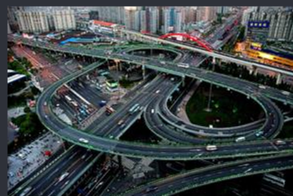
高架桥智能环保探伤破拆维修涂装
