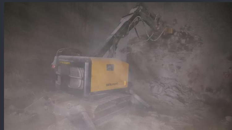
2020年4月中铁八局 重庆鱼嘴地铁隧道硬岩施工同悬臂掘进机比测
