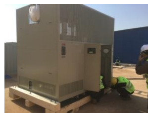
ABB变压器到货验收
