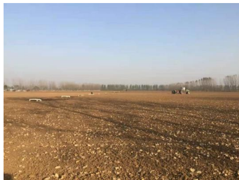
已铺设渗灌管的区域
