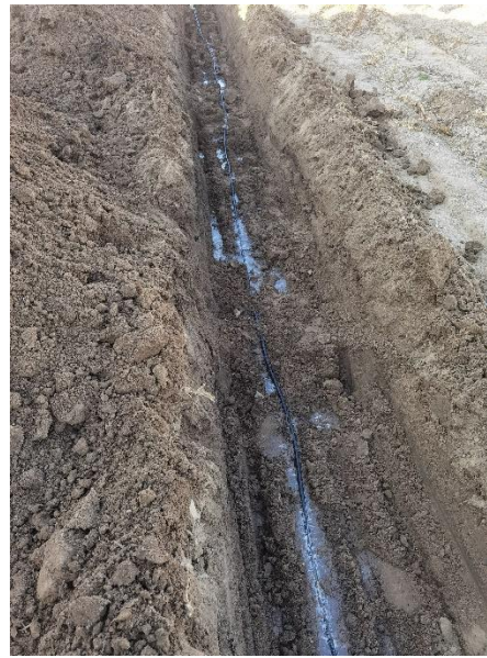
填埋之前渗灌管渗水情况
