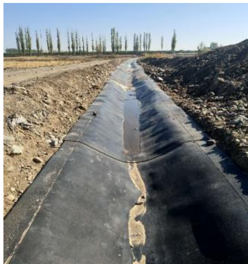
新疆：传统水泥板引水渠 一公里胶板引水渠 使用三年后的情况
