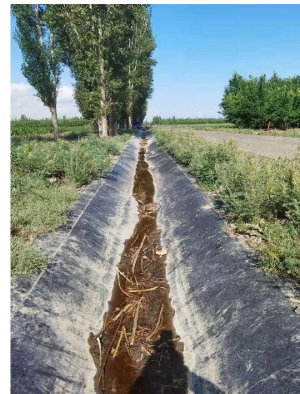
新疆：传统水泥板引水渠 一公里胶板引水渠 使用三年后的情况
