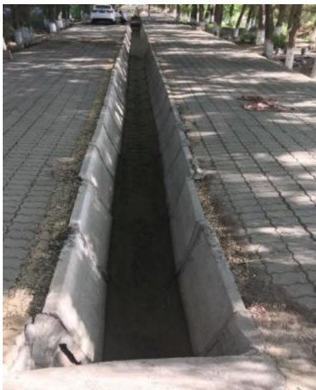
新疆：传统水泥板引水渠 一公里胶板引水渠 使用三年后的情况
