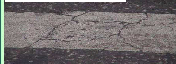
屋面防水面老化开裂
